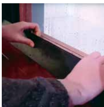
Het afneembaar profiel wordt makkelijk opengeklikt
